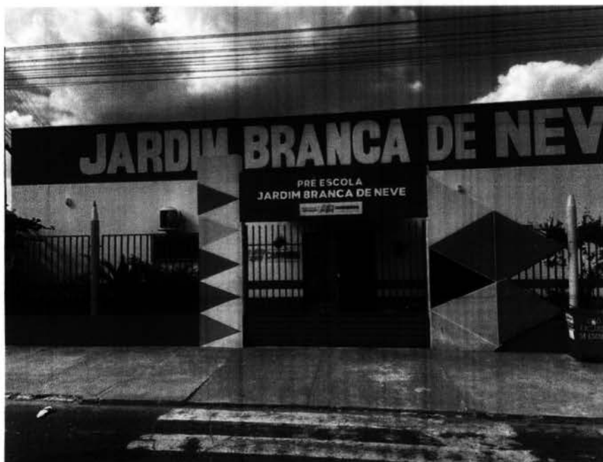
Imagem 1 – Pintura da fachada da escola.
