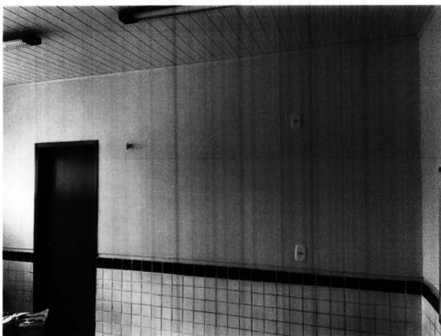
Imagem 4 – Pintura interna da escola.
