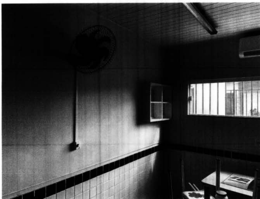
Imagem 5 – Pintura interna da escola.
