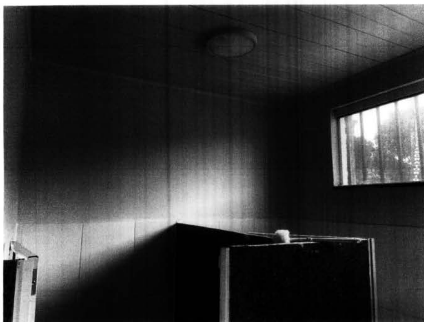
Imagem 8 – Pintura interna do banheiro da escola.
